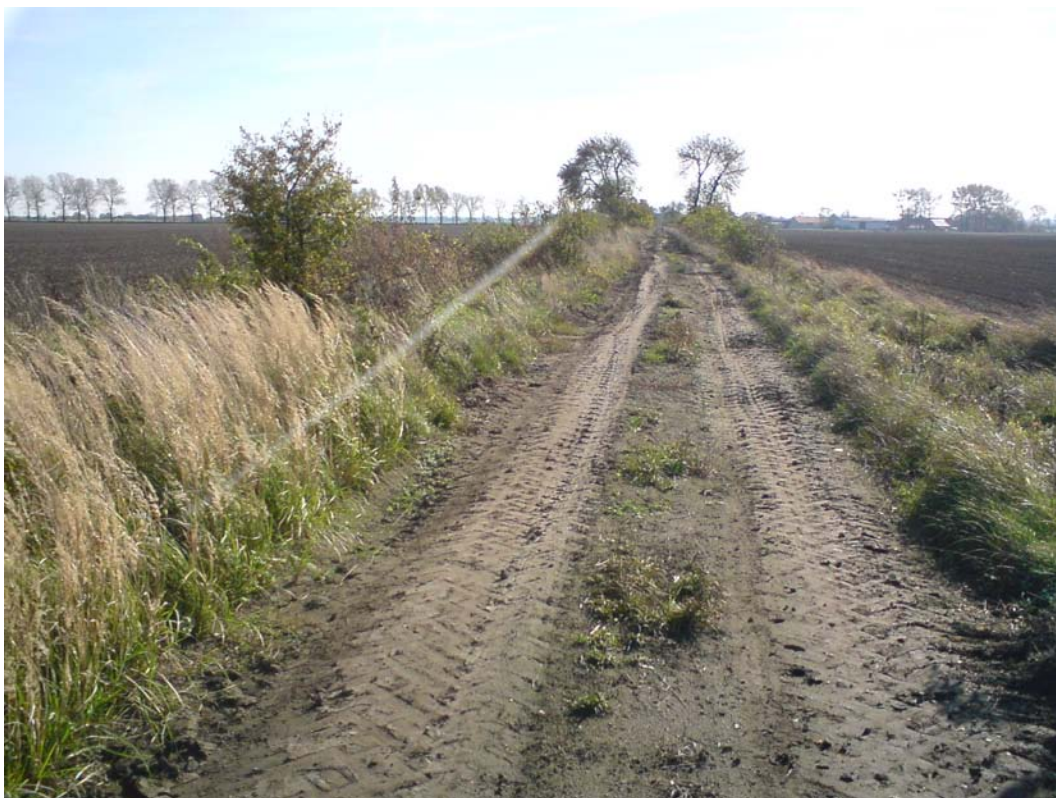
Fot. nr 34. Droga do przebudowy nr 92/1 w Kręczkowie.
