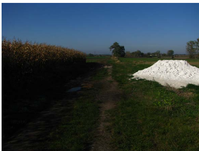
Fot. nr 32. Droga transportu rolnego nr 162 pomiędzy Jeleninem, a Kazimierzowem do przebudowy.
