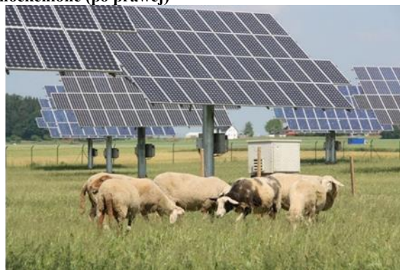
Rysunek 7 Farma fotowoltaiczna Kobern-Gondorf (lewej stronie) Rysunek 8 Zastosowanie rozwiązania agrofotowoltaiki w ramach farmy fotowoltaicznej Untermöckenlohe (po prawej)
