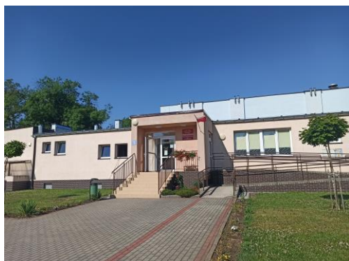
Remont dachu budynku Gminnej Biblioteki Publicznej w Borowie, filia w Borku Strzeleńskim
