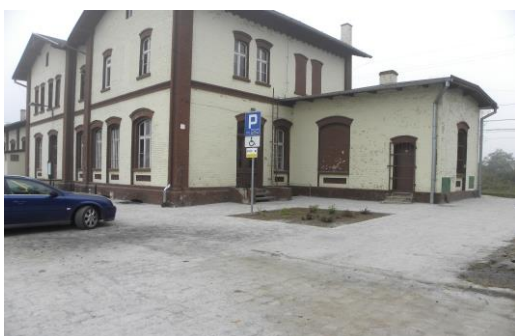
Przebudowa drogi w Boreczku
