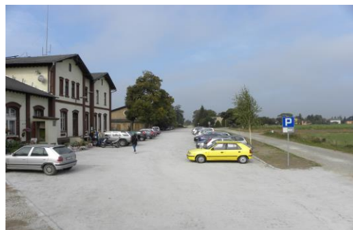
Przebudowa drogi w Boreczku
